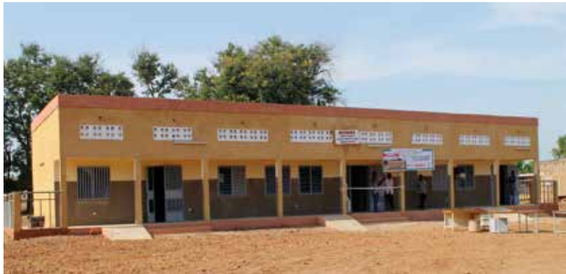
Ce bâtiment neuf est un ouf de soulagement pour l'école "C" de Kotoura
